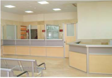
اجرای کانتر و گیشه
